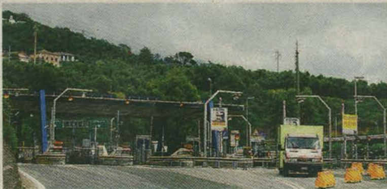
La barriera autostradale di Lavagna
